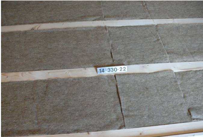
Bild 1: Rahmenkonstruktion mit Bedämpfung
