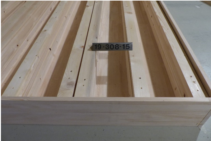
Bild 1: Rahmen mit Unterkonstruktion, Teilansicht
