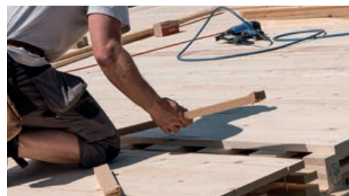
Pose de bandes absorbantes sur les joints latéraux des éléments
