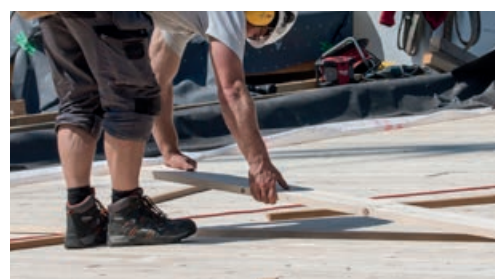
Mise en place de la planche de liaison, (pas représenté : agrafage selon la statique)
