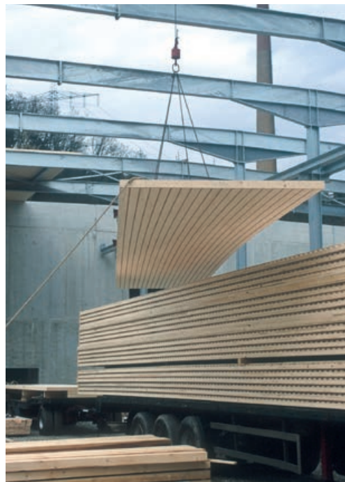
Pose d'éléments de grande surface prémontés
