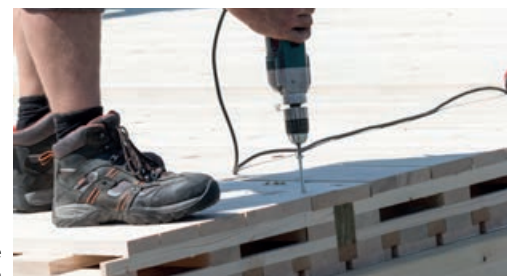
Anschluss der Scheibe an Binder bzw. Wandrähm
