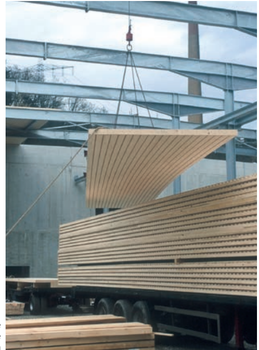
Vormontierte Grossflächenelemente beim Verlegen
