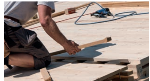
Einlegen des Absorberstreifens am seitlichen Elementstoss
