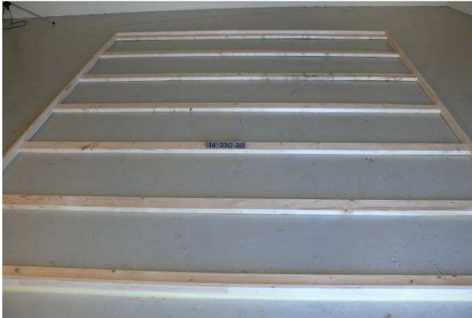
Bild 1: Rahmenkonstruktion ohne zusätzliche Bedämpfung
