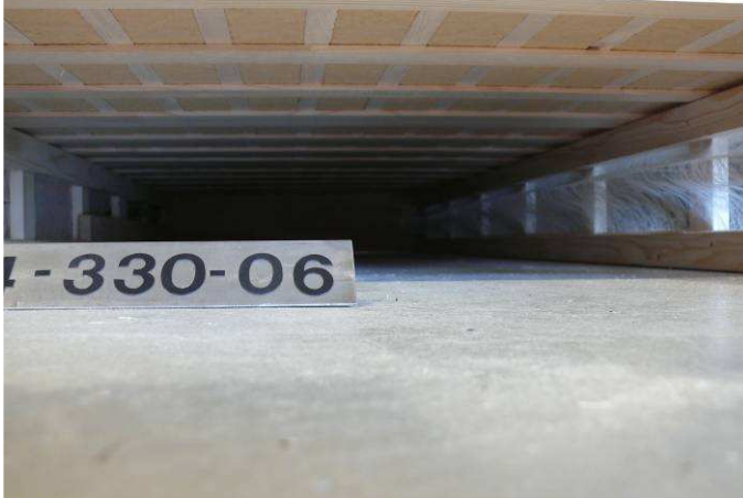
Bild 1: Ansicht Tragkonstruktion mit Plattenrückseite
