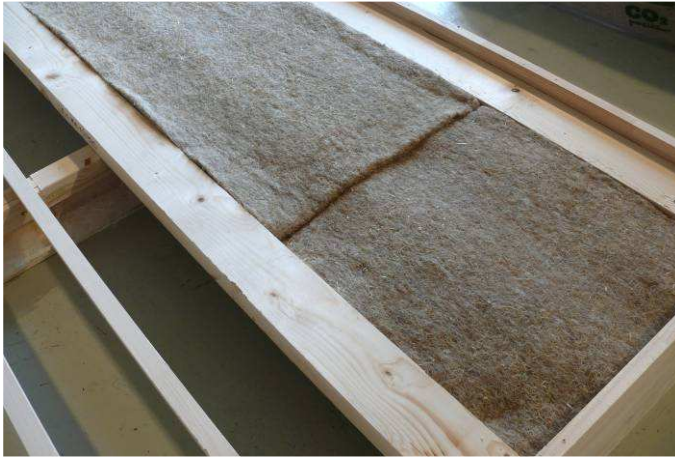
Bild 1: Ansicht Tragkonstruktion mit Bedämpfung
