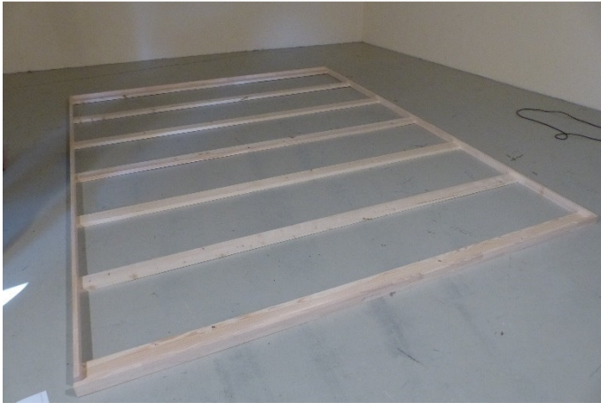
Bild 1: Rahmen mit Tragkonstruktion
