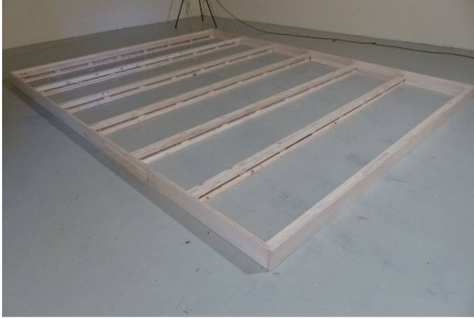
Bild 1: Rahmen mit Tragkonstruktion
