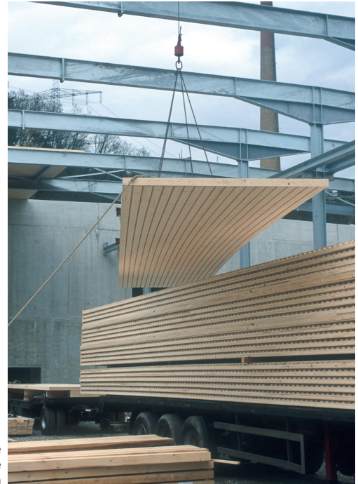
Vormontierte Grossflächenelemente beim Verlegen
