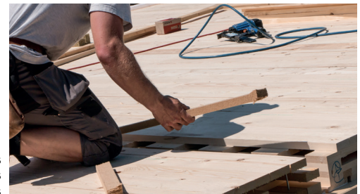
Einlegen des Absorberstreifens am seitlichen Elementstoss
