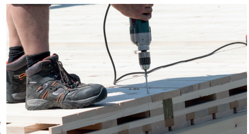
Anschluss der Scheibe an Binder bzw. Wandrähm
