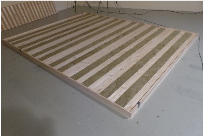
Bild 1: Rahmen mit Unterkonstruktion und Dämmung
